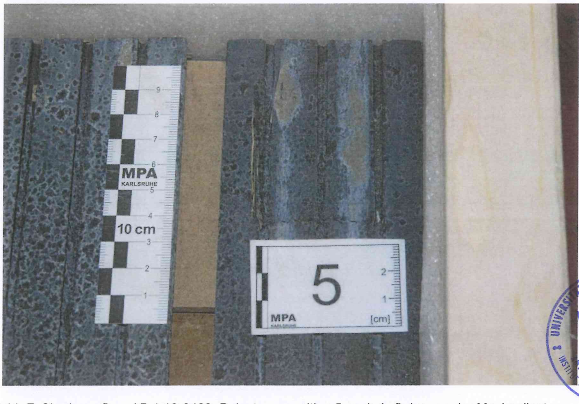
Bild 11: Fußbodenaufbau AB 1 13-0463, Belastungsposition 5 nach Aufbringung der Maximallast
